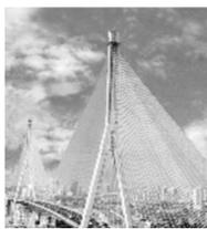
**解析:**把两根钢索的拉力看成沿钢索方向的两个分力,以它们为邻边画出一个平行四边形,其对角线就表示它们的合力。由对称性可知,合力方向一定沿塔柱竖直向下。
