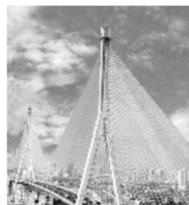
**解析:**把两根钢索的拉力看成沿钢索方向的两个分力,以它们为邻边画出一个平行四边形,其对角线就表示它们的合力,如图所示。由对称性可知,合力方向一定沿塔柱竖直向下。
