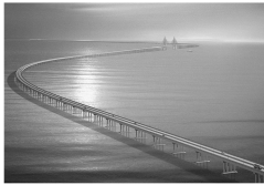
②杭州湾大桥
