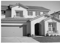
B住宅小区局部
