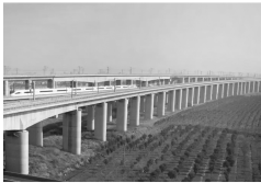
①京沪高铁陆桥
