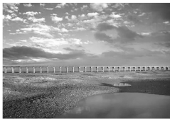
④青海清水河特大桥
